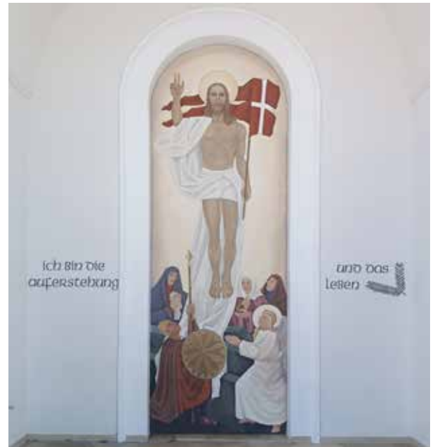
Gesamtaufnahme des Wandgemäldes mit Beschriftung im restaurierten Zustand Ende 2025
