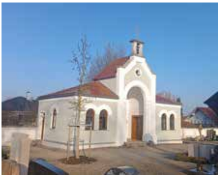
Das renovierte Leichenhaus von Südosten
